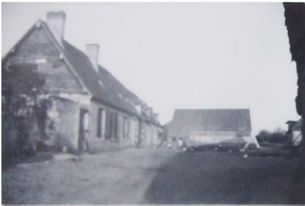
A gauche : le corps de bâtiments avec la maison d'habitation et les étables au fond Au fond : la maillère précédée du fumier A droite au fond on aperçoit la grange 2
