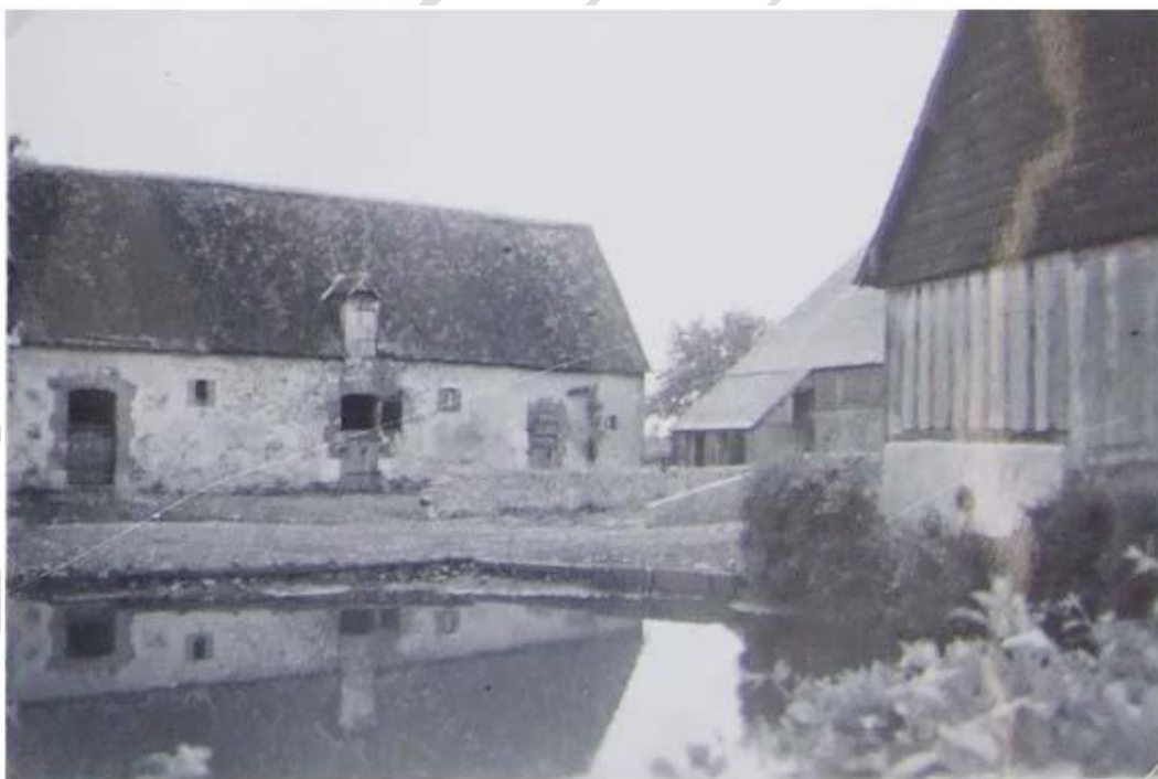
Vue prise derrière la mare : En face portes d'une étable et de la grange 1 A droite, au premier plan la gage 2 dont on voit le torchis et les poutres de bois Au 2 e plan, murs bas délimitant l'emplacement du fumier
